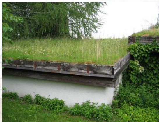
Apželdintas mokyklos techninio pastato stogas
